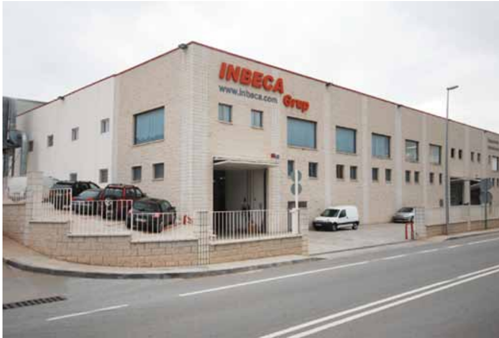
Instalaciones productivas INBECA. Cervelló (Barcelona)
