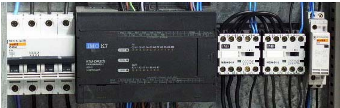
Diferencial general Magnetotermico de maniobras Magnetotermico calefactor Contactor seguridad calefactor Contactor maniobras calefactor
