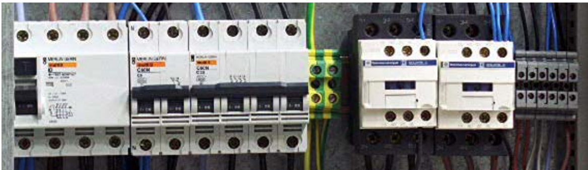
Diferencial general Magnetotermico de maniobras Magnetotermico calefactor Contactor seguridad calefactor Contactor maniobras calefactor
